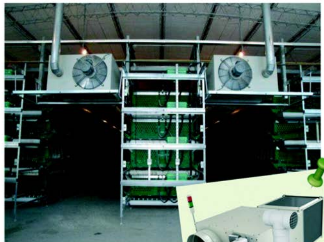
Calefacción por AIRE CALIENTE LIMPIO para recia de ponedoras
